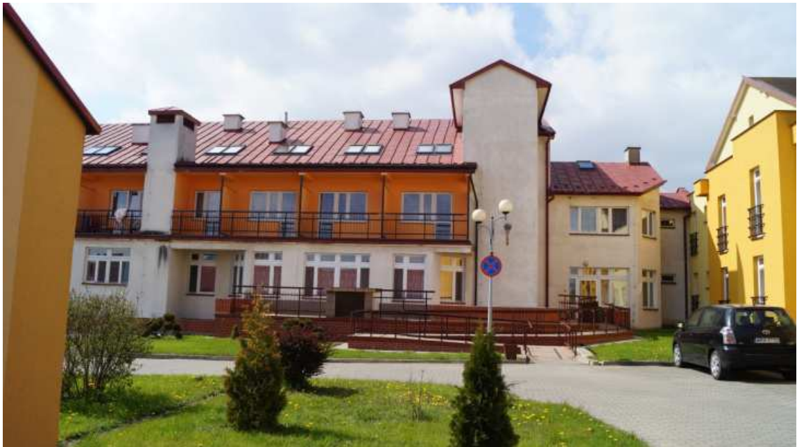
Fot. 1. Widok elewacji frontowej NW.
