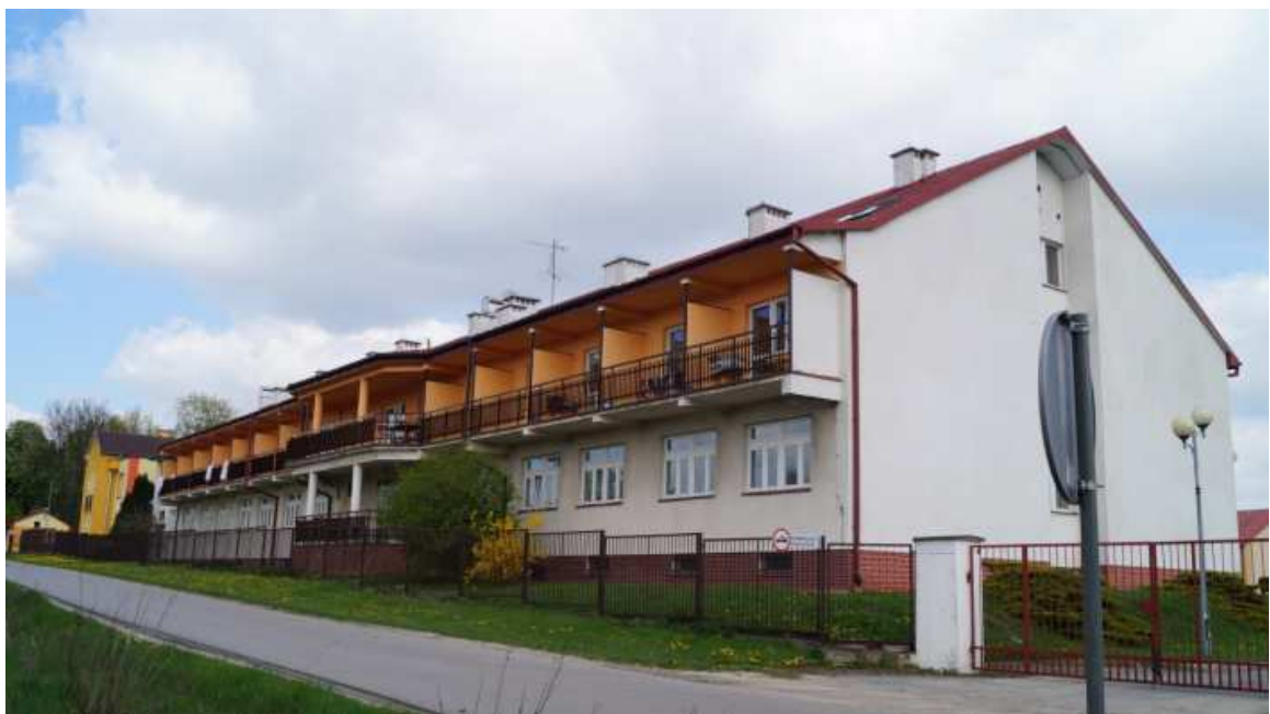
Fot. 1. Widok elewacji szczytowej NE.
