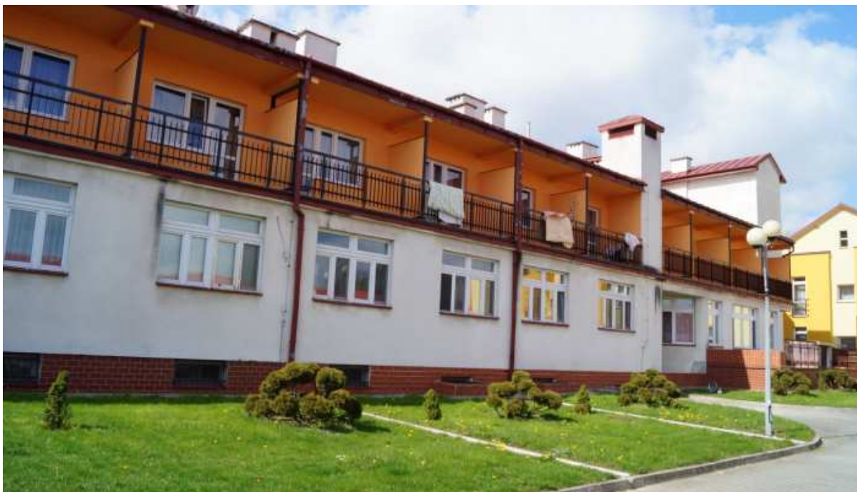
Fot. 3. Widok elewacji SE.
