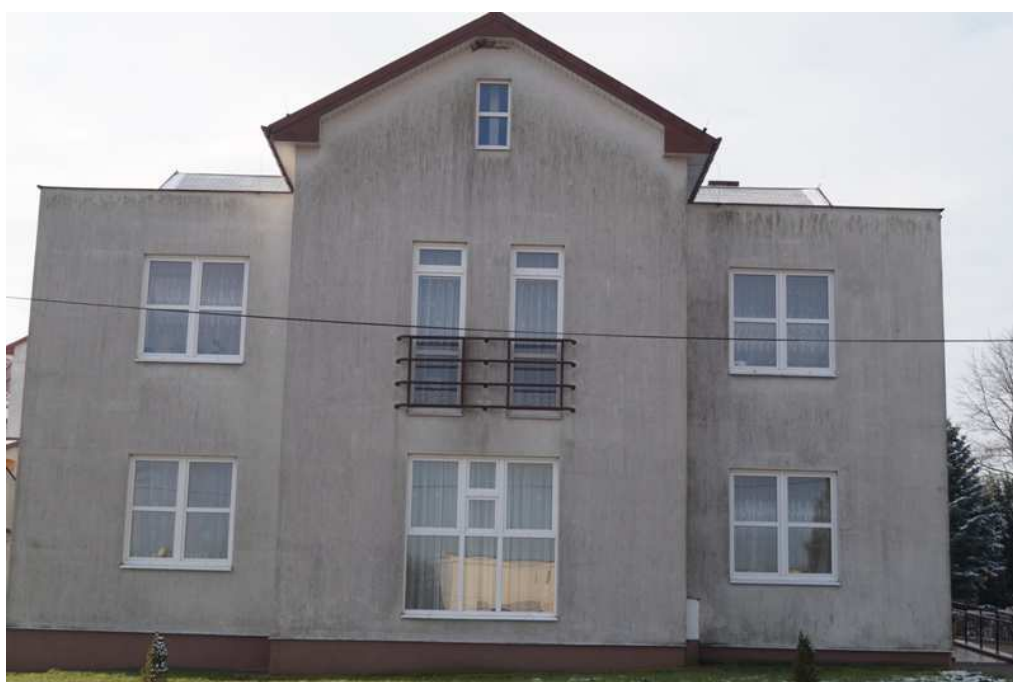
Fot. 1. Widok elewacji szczytowej NE.
