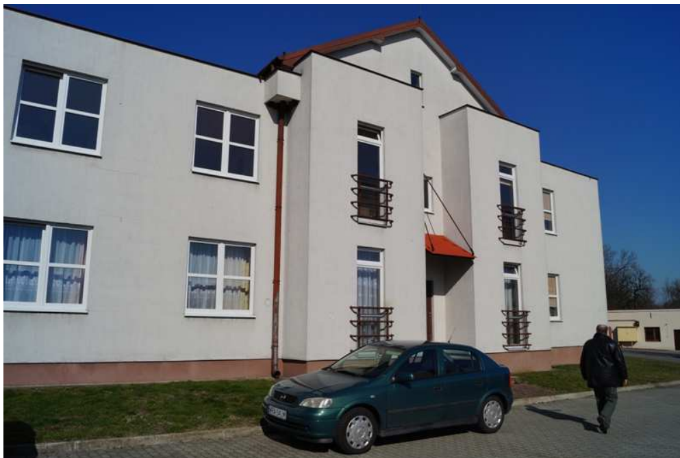
Fot. 3. Widok elewacji SE.
