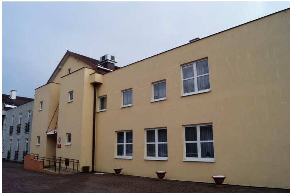
Fot. 1. Widok elewacji frontowej NW.
